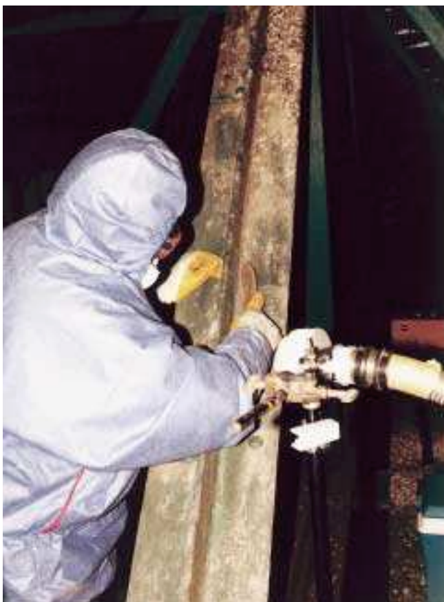
Abb. 2: Reinigung mit Bürsten
