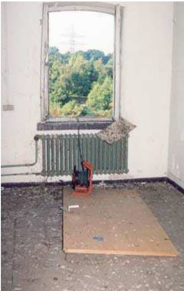
Abb. 3a, b: Taubenkotkontamination, die gut absaugbar ist
